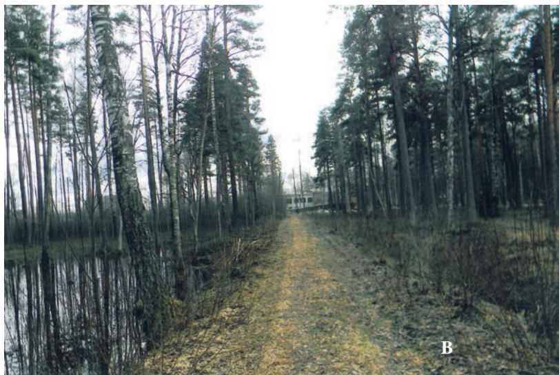
Ceļa mālainai klātnei pieguļošo mežu applūšana (A) un kokaudzes panīkšana (B) dažu metru atstatumā no sausa grāvja.
