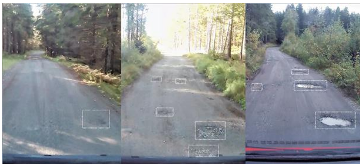
Att. 3.1. Bedru atpazīšanas piemērs dažādos laikapstākļos, izmantojot datorredzi, pētījumā Norvēģijā (Hoseini, Puliti, u.c., 2024)
