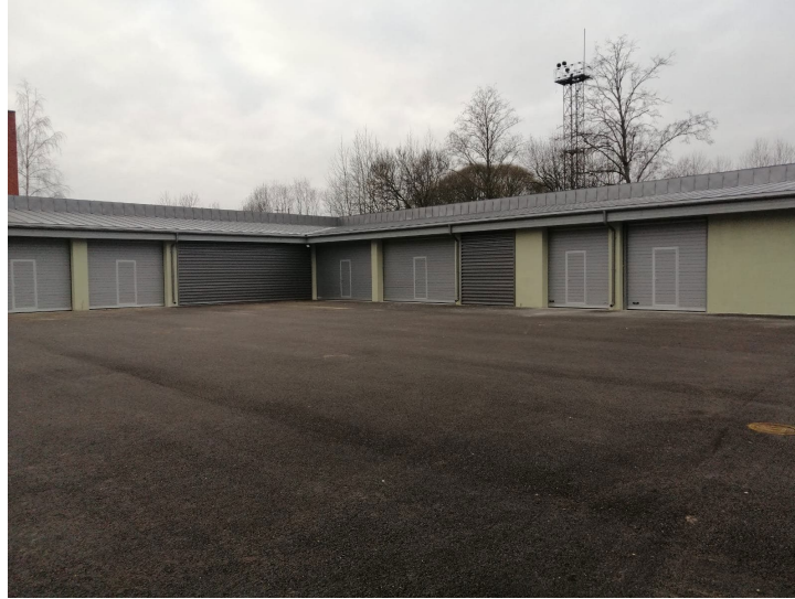
Rekonstruētās garāžu un noliktavu telpas Institūta ielā 1A, Salaspilī
