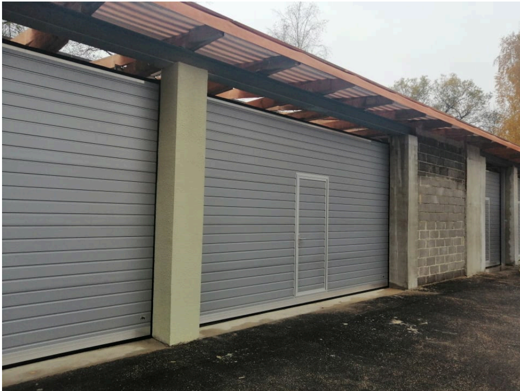
Būvdarbi LVMI Silava garāžu un noliktavu kompleksā Institūta ielā 1A, Salaspilī
