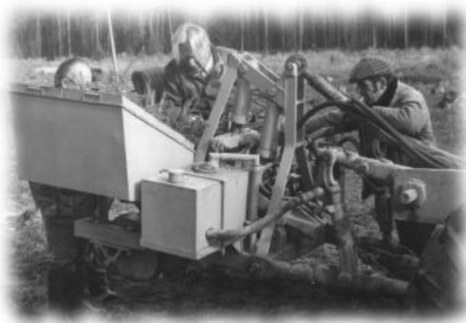
Att. 2 Stādāmā mašīna “Quickwood” (Austrija) pārveidota ietvarstādu “Brika” stādīšanai ar vienlaicīgu augsnes sagatavošanu, 80-tie gadi
